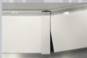
3. Der zweite Fensterbankabschnitt in den bereits vormontierten Gleitverbinder GV<sup>2</sup> von der Anschraubkante an beginnend aufstecken. Es muss auf den korrekten Sitz der Dichtlippen im Bereich der Anschraubkante geachtet werden. Sollte die Dichtung nicht ausreichend silikonisiert sein, verwenden Sie Gleitmittel / Silikon spray.
