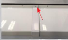
5. Fensterbank mittels geeigneten Schrauben montieren. Gleitverbinder GV<sup>2</sup> durch das vorgefertigte Anschraubloch mit Fensterbankbankschraube fest anziehen.
