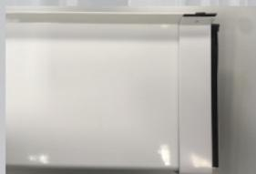
2. Gleitverbinder GV<sup>2</sup> leicht schräg ansetzen und gerade im rechten Winkel auf eine Fensterbankseite aufstecken. Bitte beachten Sie, dass die Sägeschnitte der Fensterbänke entgratet sind.
