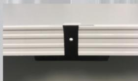
4. Kontrollieren Sie im Bereich der Anschraubkante nochmals die korrekte Verbindung der beiden Fensterbankabschnitte. Anschraubkante und Dichtschuh müssen eine Einheit ohne offene Fuge bilden.
